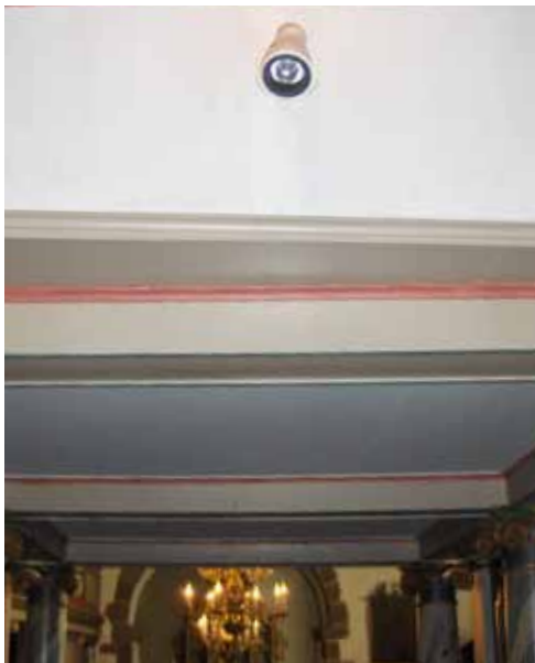
Alternativ merking av rømmingsveg. Spotlight er brukt i staden for markeringsskilt
