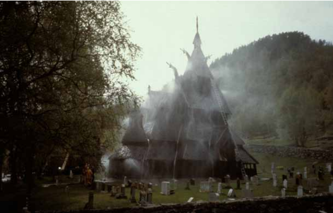
Utvendig sprinklar i funksjon
