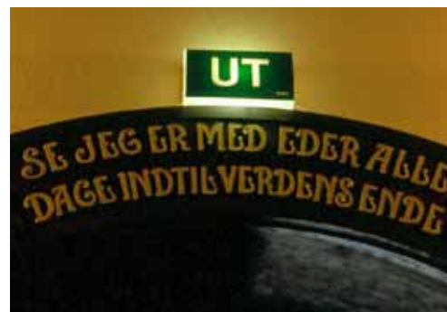
Eksempel på uheldig merking av rømmingsveg
