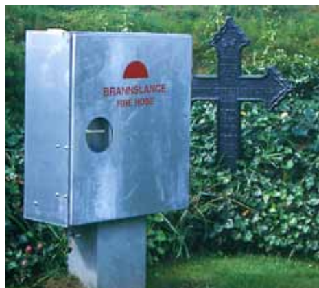
Utvendig brannslangepost
