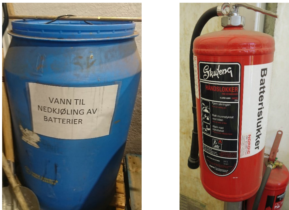
Figur 3-10 Eksempler på ulike slökkemiddel. Til venstre en tønne med vann som batterier kan puttes oppi ved varmgang. Til høyre et brannslukningsapparat beregnet for batterier. Foto: RISE Fire Research.
