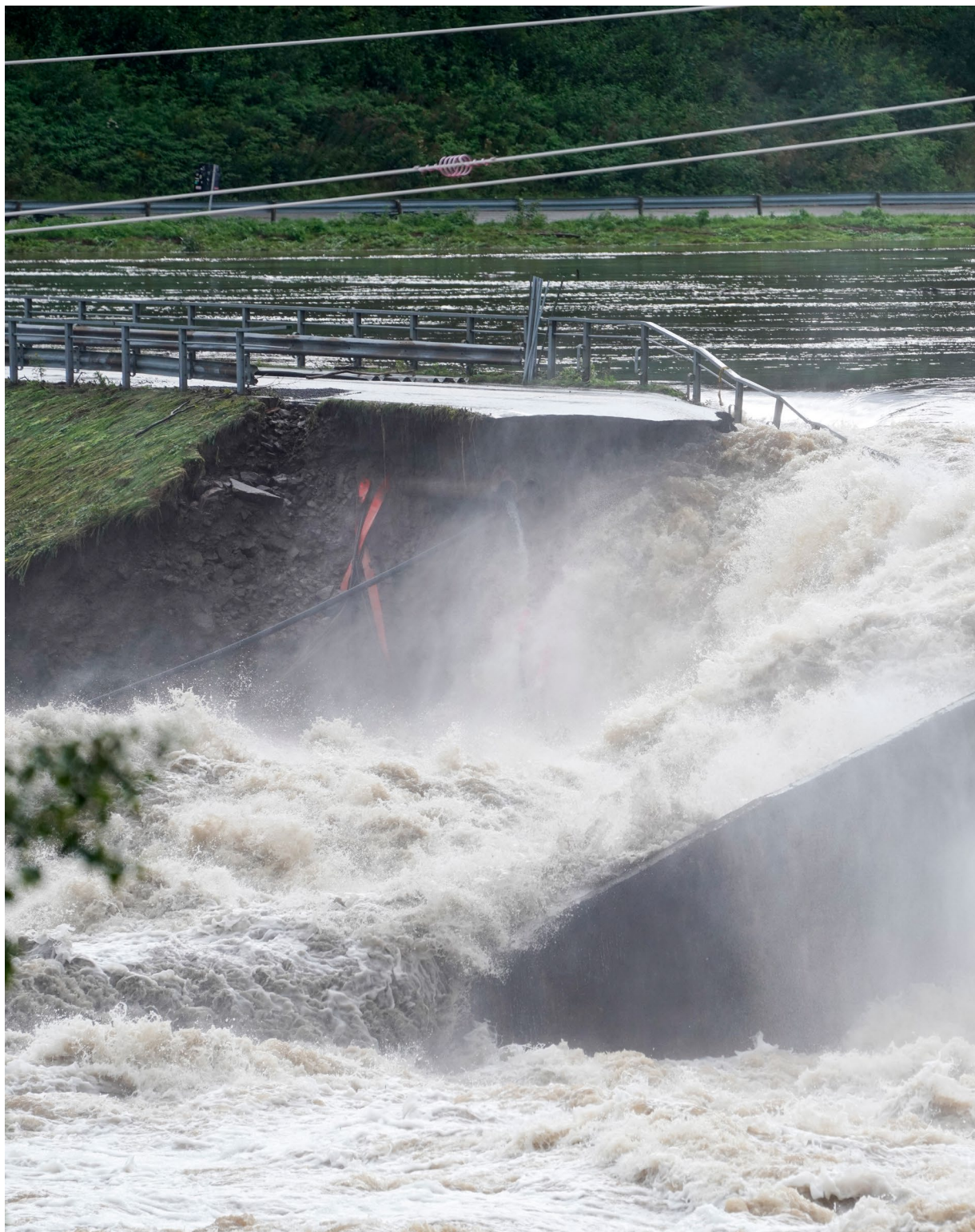
Demningen ved Braskereidfoss brister og vannet strømmer nedover Glomma. Foto: Cornelius Poppe / NTB
