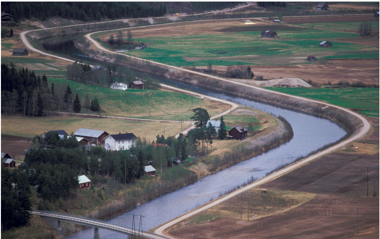
Regulert elveleie for å hindre oversvømmelse ved vårflom. Flomsikring. Elva Rena forbi Øvre Rendal. Rendalen kommune. Hedmark. Foto: © Steinar Myhr / NN / Samfoto
